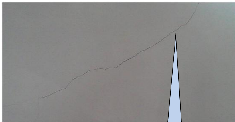
抹灰裂缝
