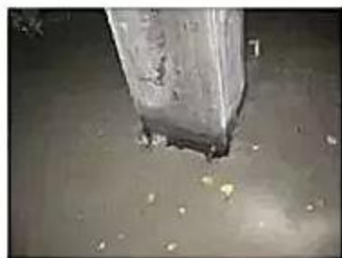
(1) 成品烟道安装、固定
