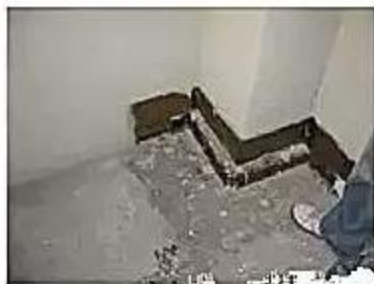
(4) 试水后防水处理
