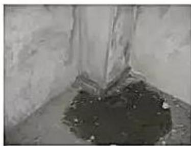
(2) 烟道根部浇筑砼反坎
